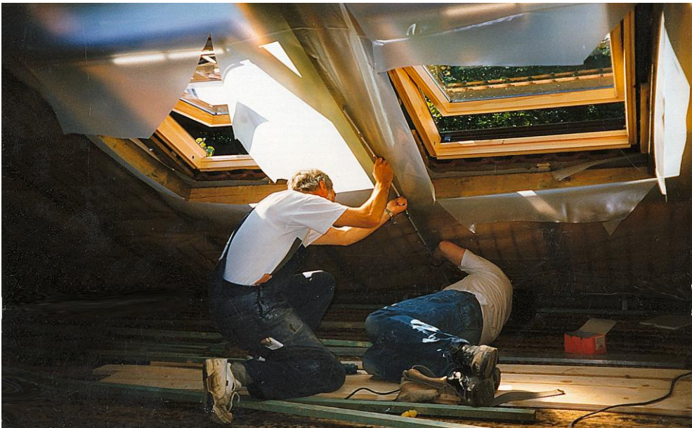
Abb. 59: 1997 - Ausbau des Dachgeschossausbau durch die fleißigen Helfer des Fördervereins
