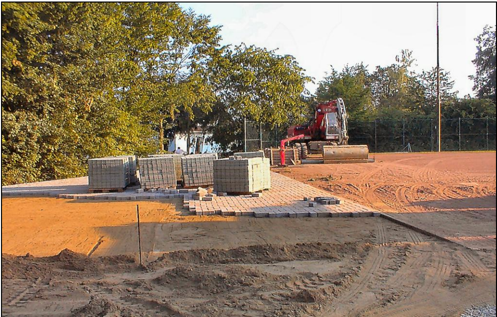
Abb. 34: August 2004 – ... bald ist der neue Parkplatz fertiggestellt.
