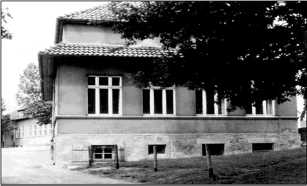
Abb. 17: 1968 – Im Bild die sogenannte »Kleine Schule« von 1925, dahinter das Gemeindehaus der Kirchengemeinde Exter (bis 1964 die alte Volksschule im Ort).
