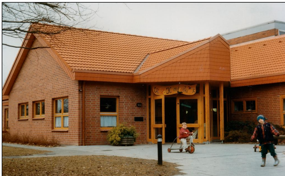
Abb. 57: 1995 - Die neue Außenansicht
