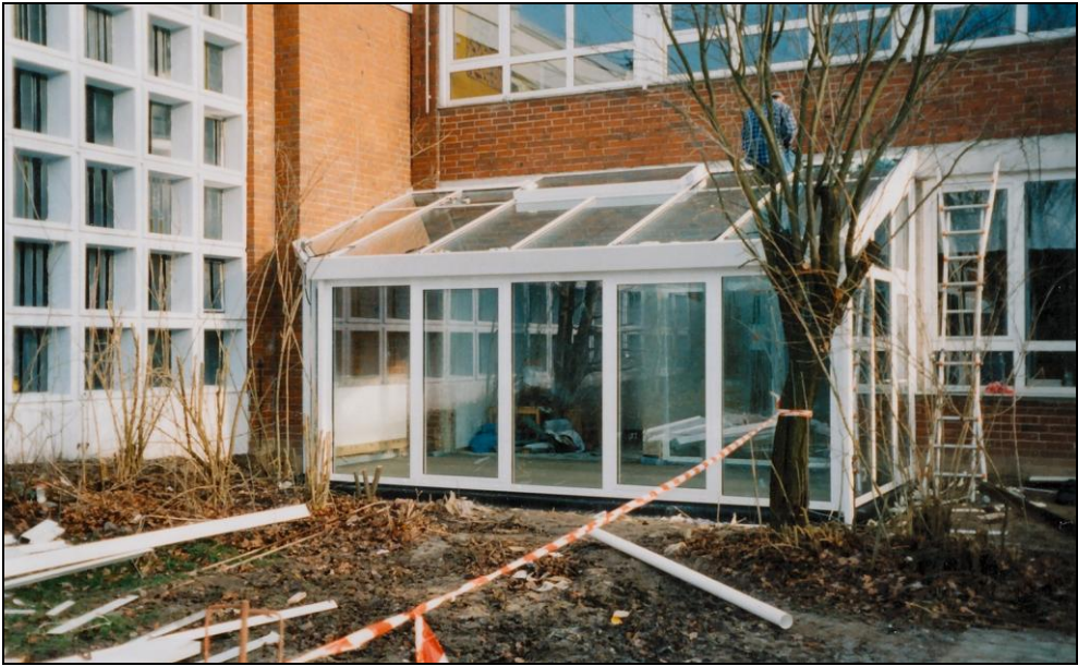
Abb. 62: 1999 - der fertig ausgebaute Wintergarten
