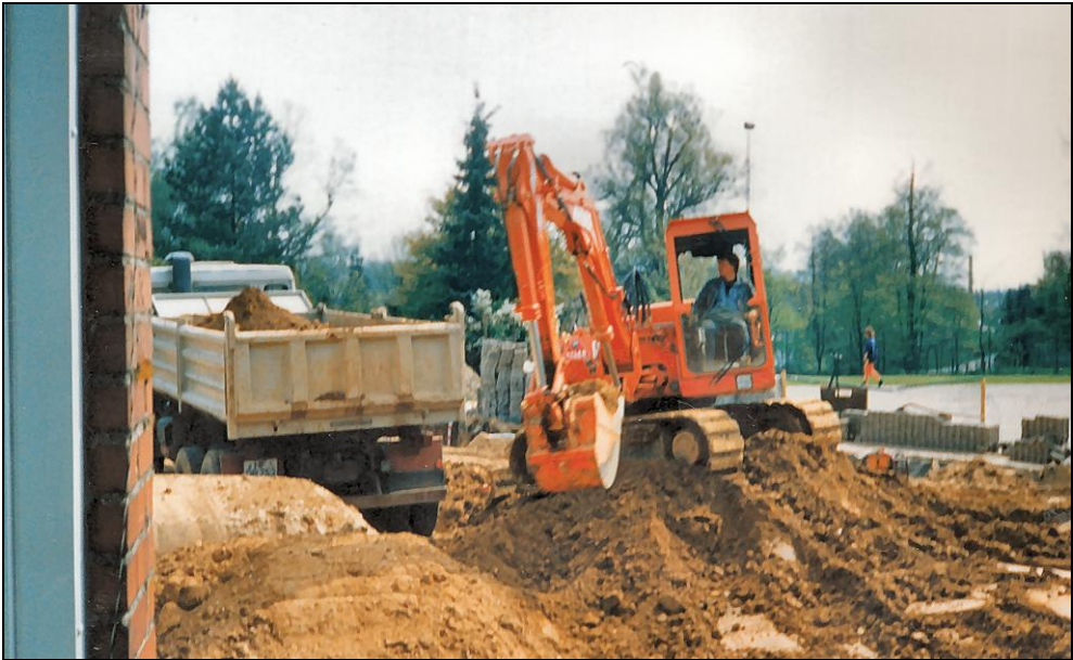
Abb. 51: 1993 - Erweiterung des Kindergartens
