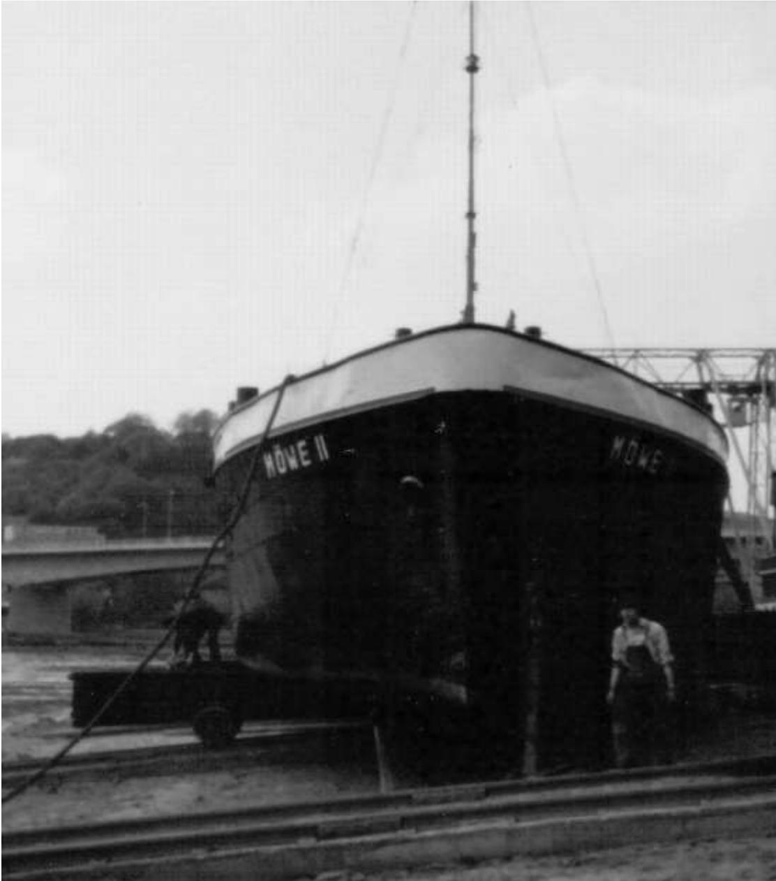
(1982) Die „Möwe II“ liegt auf dem Helgen der Werft Büsching & Rosemeyer in Uffeln. Der Schepper (vorn) ist dabei, den Boden und die Bordwände außen zu teeren.
